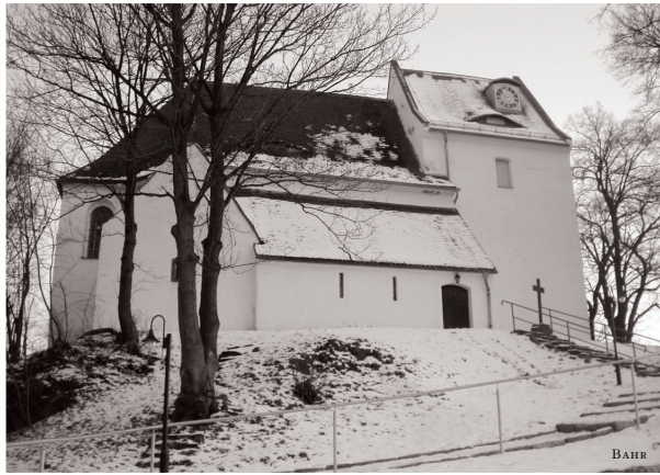
Wehrkirche mit Südaufgang
